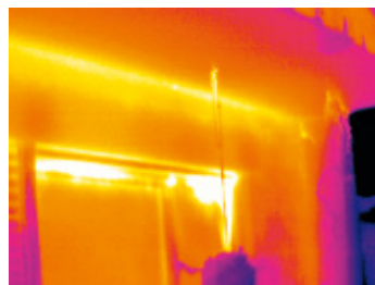
Nachträglich gedämmter Rollladenkasten ist wärmetechnisch besser als Mauerwerk
